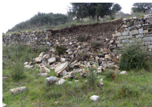
Effondrement de mur lié au castrum après des pluies diluviennes au château de Termes en 2024 © Hannes Ceulemans
