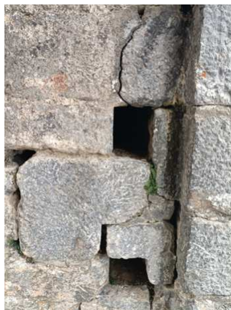
Fissure dans les maçonneries du château de Montségur probablement due à un impact de foudre ©Fabrice Chambon
